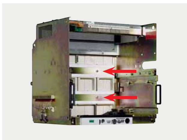
Обязательные для всех аппаратов DMX шторки защищают от прикосновения к частям аппарата, находящимся под напряжением
