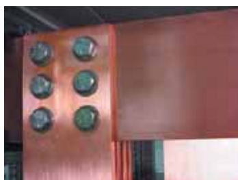
Соединение шин 120 x 10 (4000 A)
