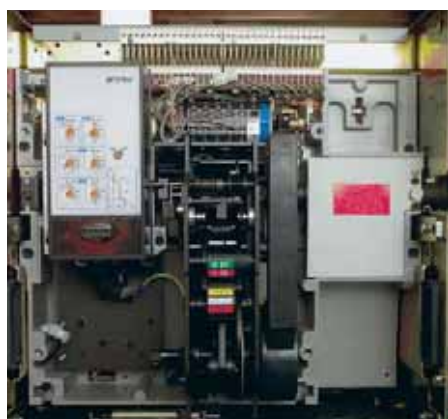
Расцепитель в выкатном аппарате DMX 2500
