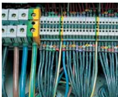
Клеммы Viking: надежное решение для присоединения гибких проводников
