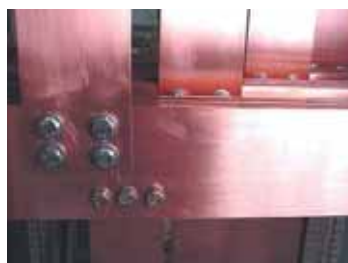
Двойное соединение: шины 100 x 10 (3200 A) и шины 80 x 10 (2500 A) закреплены на шинах 120 x 10
