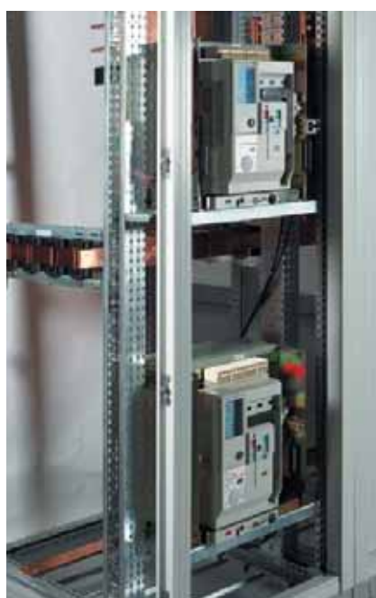
Автоматические выключатели DMX в режиме АВР
