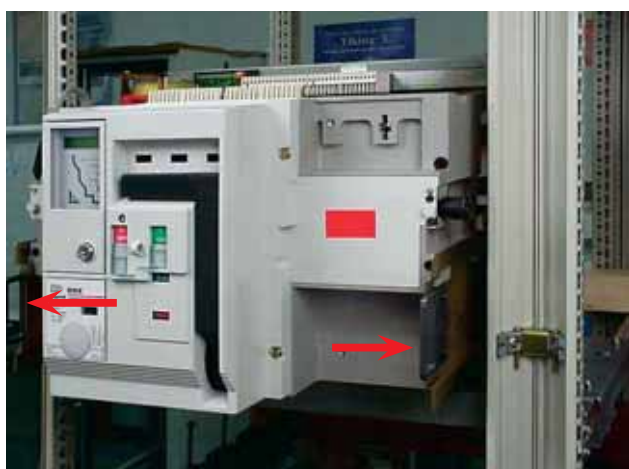
Для выкатывания аппарата используются специальные рукоятки
