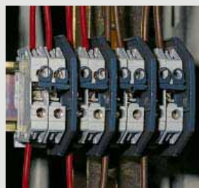
Присоединение дополнительных проводников к клеммам Viking с использованием разделяемой перемычки
