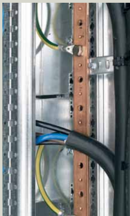
Медная шина сечением 32 x 5 мм для подсоединения нулевых защитных проводников
