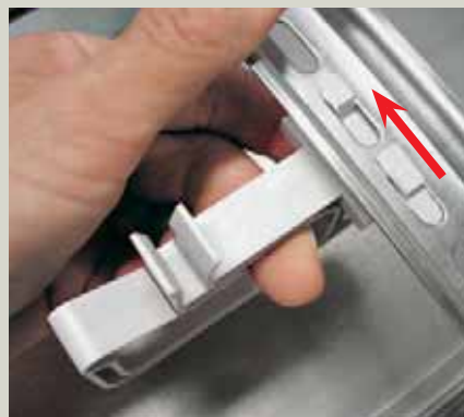
Установка держателя горизонтальных проводов
