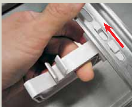
Установка держателя горизонтальных проводов.
